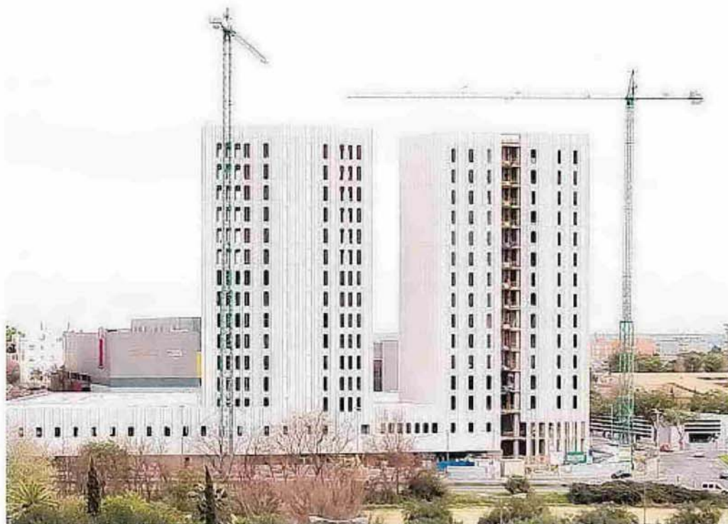
Sobre estas líneas, las torres que se construyen en Ciudad Expo
